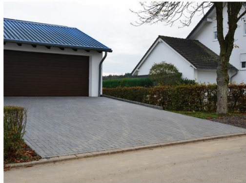
Tiefbau und Aussenanlagen
